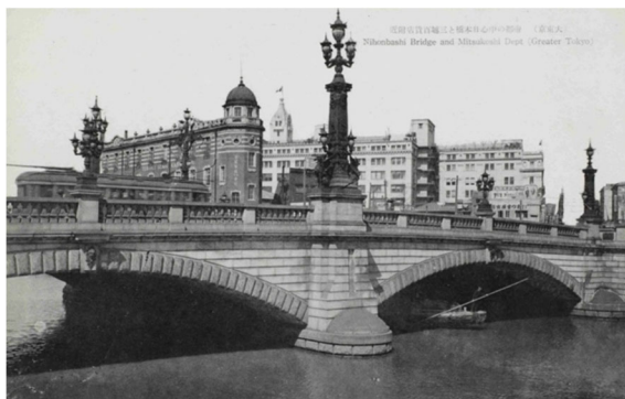
図 2. 日本橋、1904 年頃（絵葉書「帝都の中心 日本橋と三越百貨店付近」、東京都立図書館）
