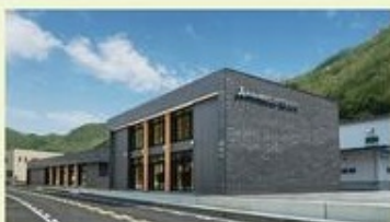
社員の食と体と心の健康を維持するために整備した福利厚生棟
