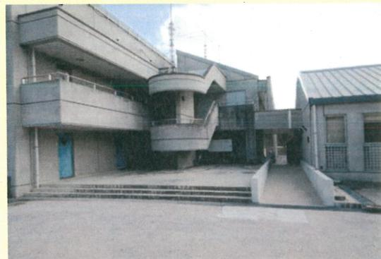
部室がある棟には階段しか設置しておらず、車椅子で進入できなかったため、スロープを新設した。その他にもパソコン教室のOAフロアやテニスコートの入り口などにもスロープを新設した。
