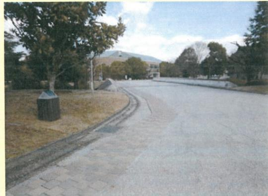
学内の路面が風化により砂利がむき出しの状態になり、車椅子での移動において「振動が強い」「前輪が取られ操作が難しい」「移動に時間がかかる」などの問題が生じたため、低振動ブロックを約200mにわたり敷き詰めて走行路を作成した。
